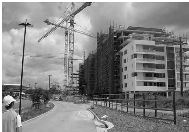
マンション建設現場
