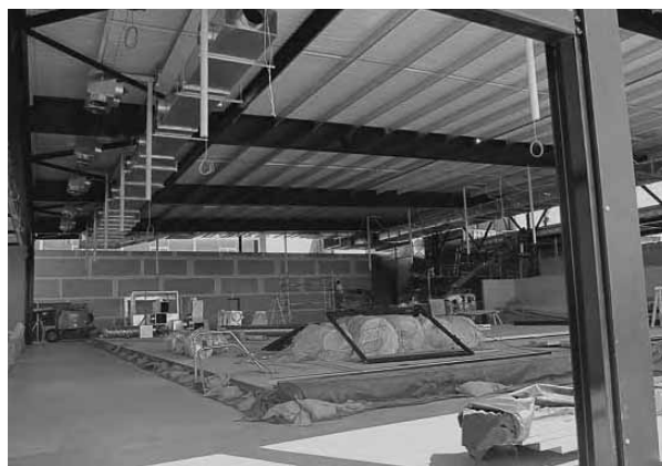
現場視察 - 学校屋内プール改修工事
